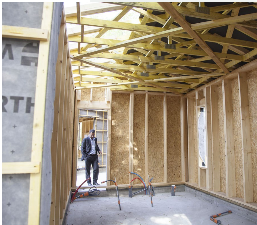
Visite de chantier, Constructions Robert Cassagne, Léon (40)
